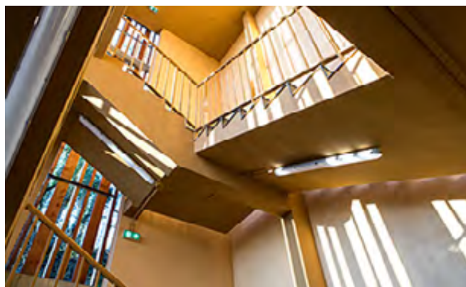
Dispositif laissant passer la lumière – Parking Relais de la gare d'Étampes (91)
