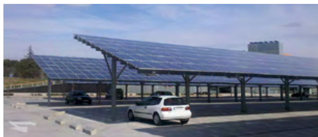
Ombrières de parc de stationnement
