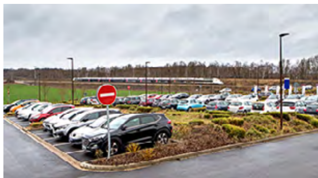
Noues de récupération des eaux pluviales du parking de Longvilliers (78)
