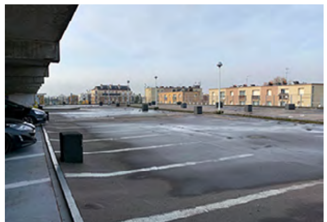
Parking surdimensionné - La Varenne-Saint-Hilaire (94) / Chennevières-sur-Marne (94)
