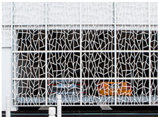
Dispositif de façade laissant passer la lumière – Parking Relais de la gare d'Esbly (77)
