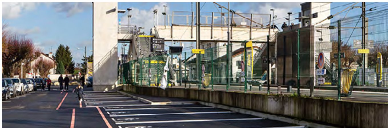
Places PMR du Parking Relais de la gare d'Esbly (77)
