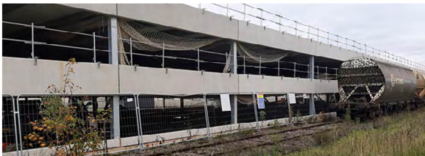
Travaux du Parking Relais de Nangis (77)
