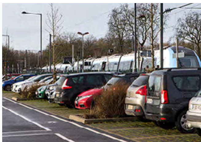
Parking Relais drainant à remplissage mixte de la gare de Marles-en-Brie (77)
