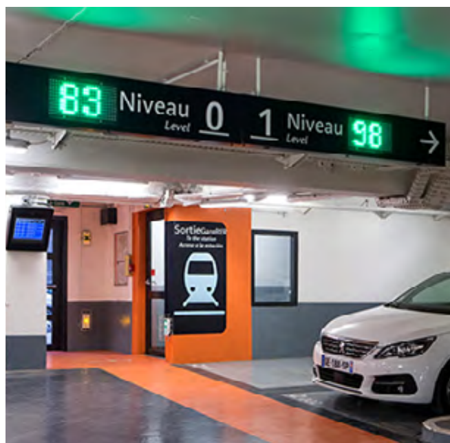
Information dynamique disponibilité de places et horaires des transports en temps réel au Parking Relais de la gare de Cergy-Préfecture (95)
