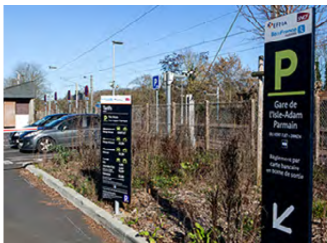
Signalisation statique du Parking Relais de la gare de l'Isle-Adam-Parmain (95)
