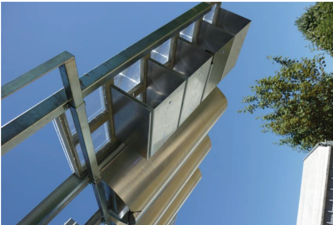
Figure 10 - Exemple de mât d'éclairage naturel
