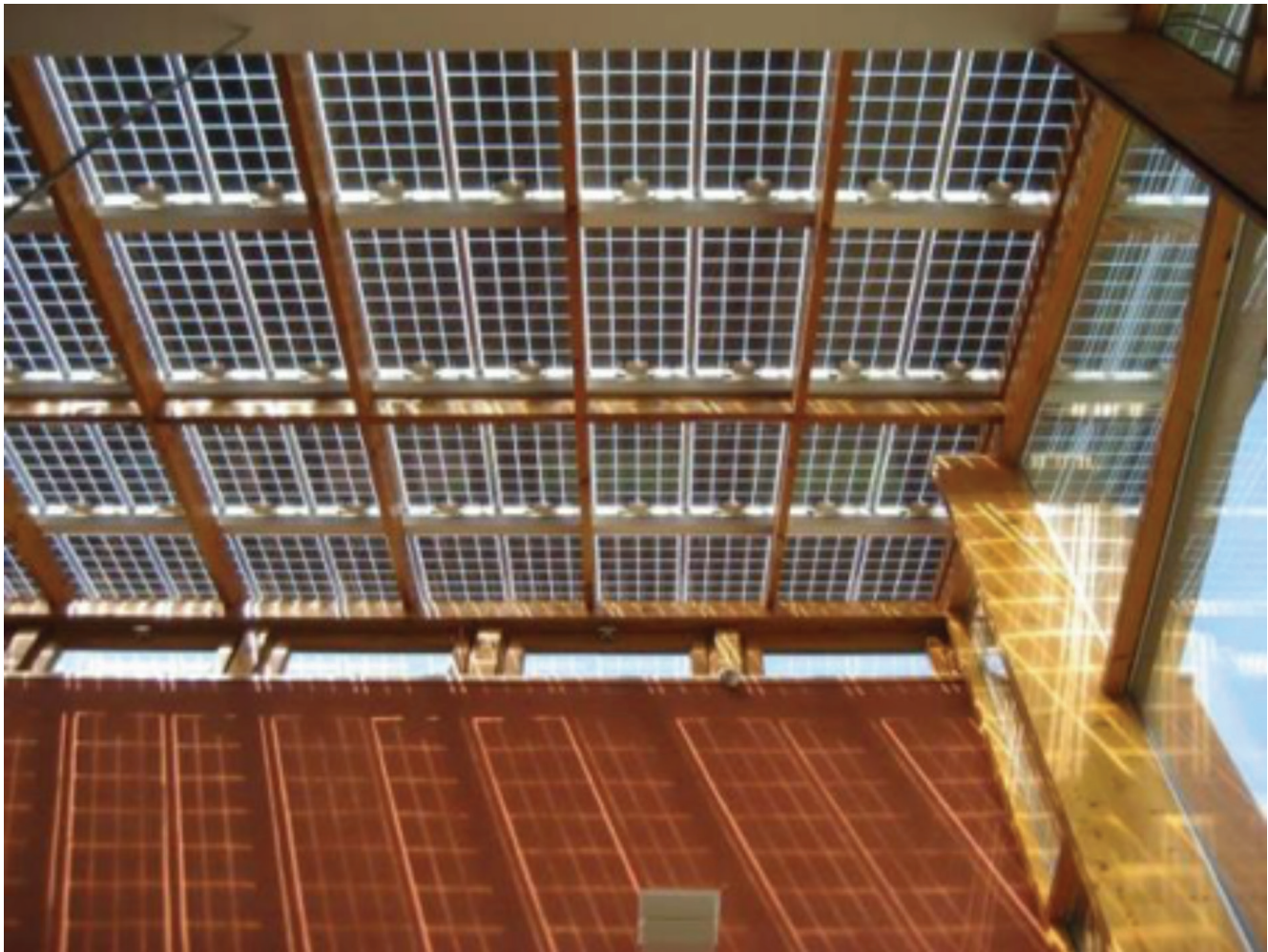
Figure 11 - Exemple de cellules PV bi-verre
