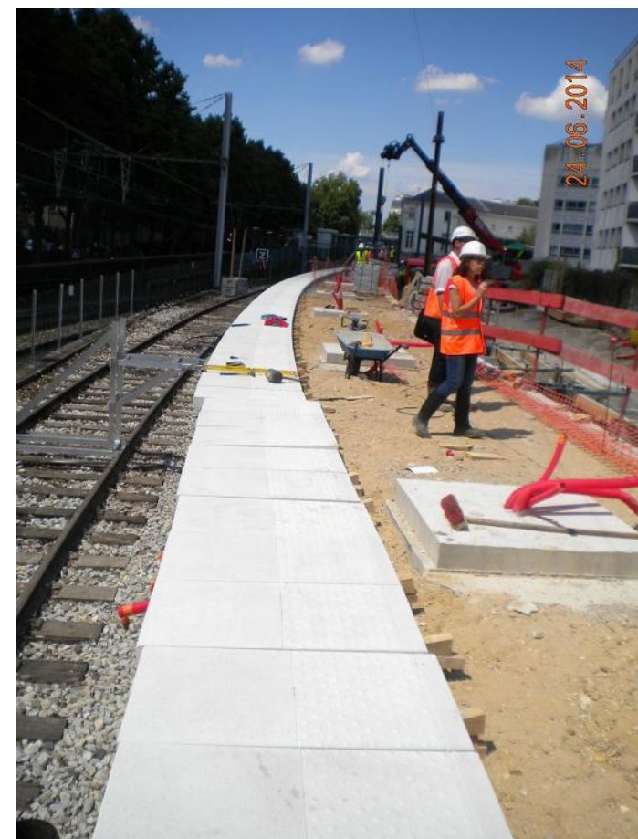
Pose des nez de quais
