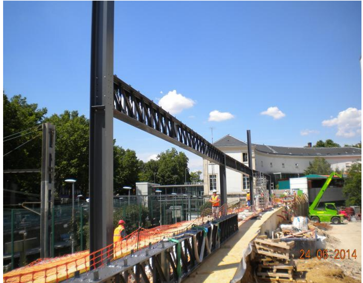
Pose de la marquise
