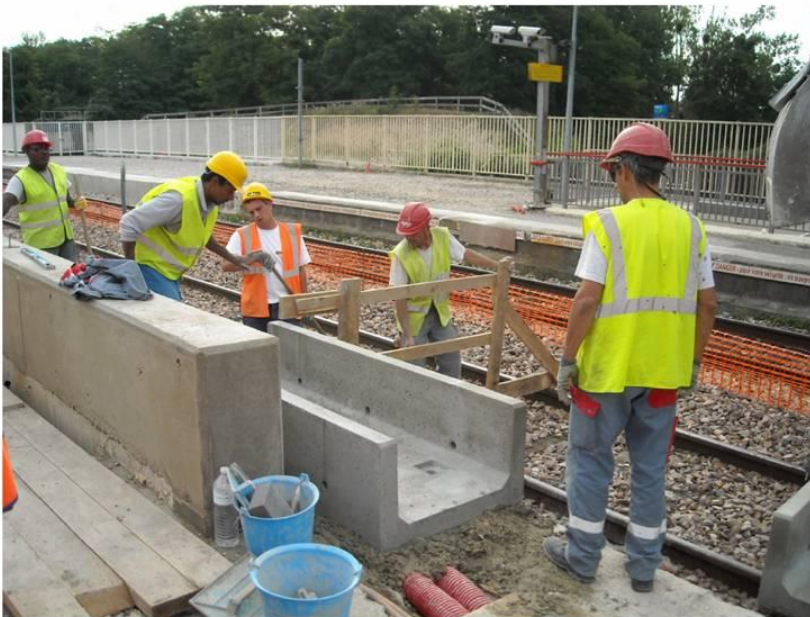
Les travaux B Nord +
