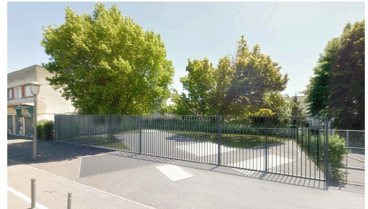
Figure 50 : Insertion des grilles au sol de l'OA 3500P
