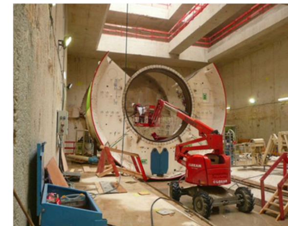
Figure 8 : Exemple de montage du bouclier en fond de puits
