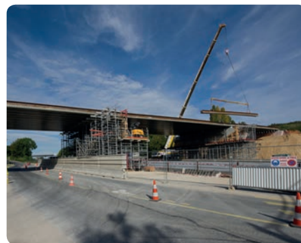
© Christophe Recoura / STIF. Chantier de l'Express 91-06.
