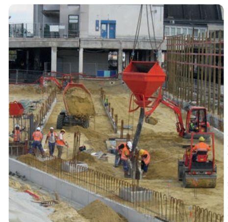
© SNCF. Chantier du bâtiment voyageurs du pôle de Versailles-Chantiers.
