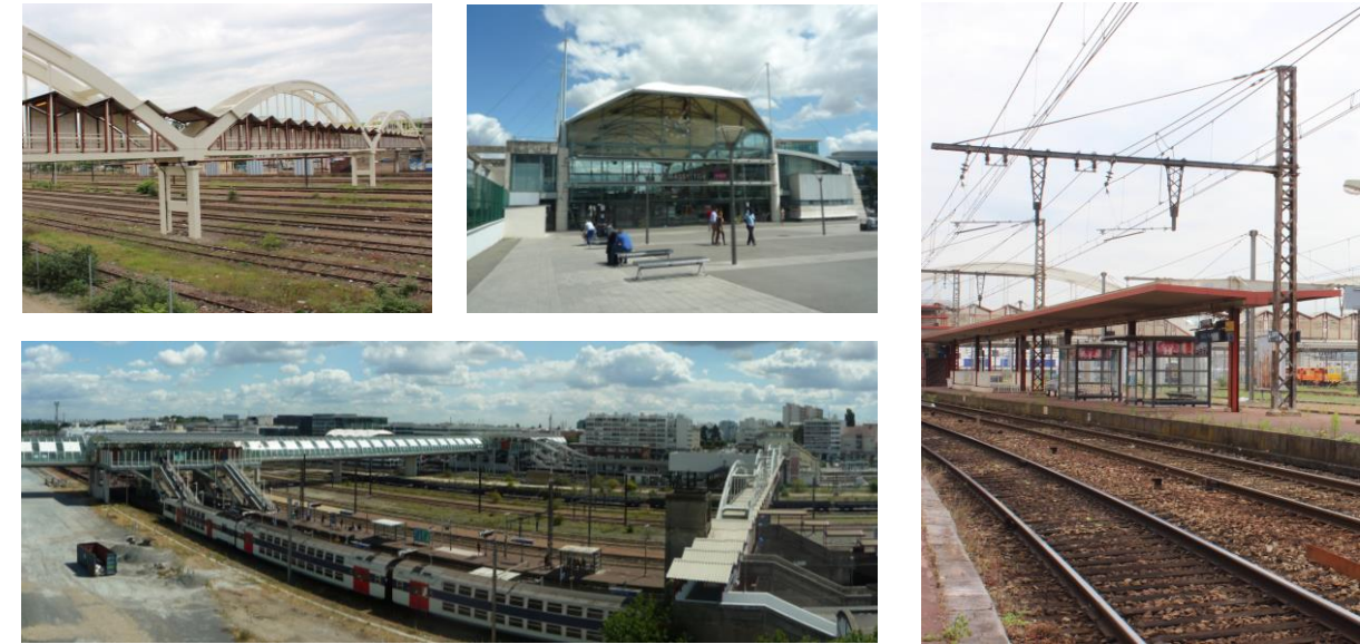
Figure 92 : vues du site
