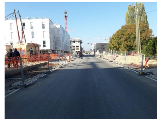
Vue du quartier en construction
