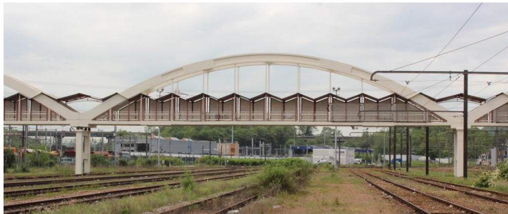
Figure 90 : photographie du bâti depuis les voies SNCF, passerelle historique
