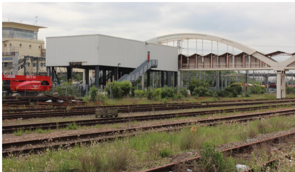
Figure 91 : photographie du bâti depuis les voies SNCF, local technique
