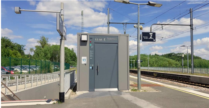
Toilettes PMR de Bourron-Marlotte, mis en service été 2023
