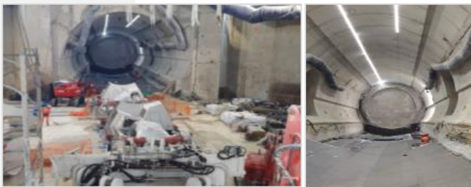
La Dhuis : Voûte terminée
