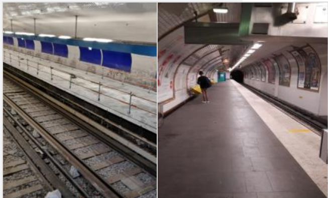
Châtelet : Voies 2 et 4 terminées
