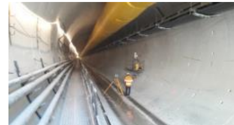
Creusement du tunnelier « Claire » depuis la gare PDR
