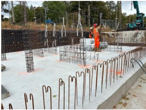
Sous station Bois le Roi : Génie civil
