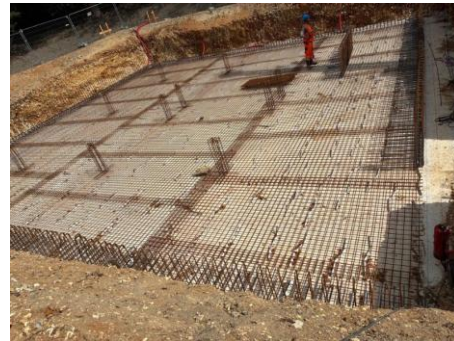
Sous station de Cépoï : mise à la terre
