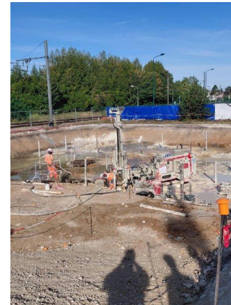
Sous station Souppes: pose de micro pieux
