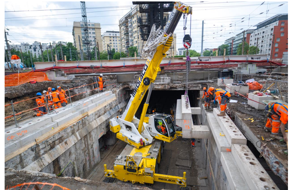
Pose des sommiers à l'aide d'une grue routière depuis le RER C
