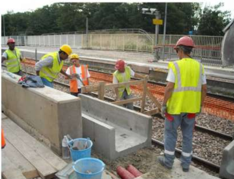
Les travaux B Nord +
