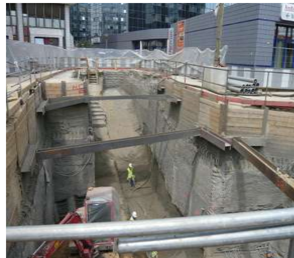
Val de Fontenay : travaux en cours de création d'un nouvel accès
