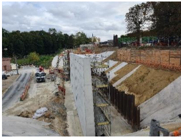
Futur terminus de Saint-Germain-en-Laye – Mur de soutènement
